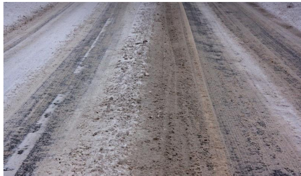
Figuur 10: een weg die werd behandeld met strooizouten.
